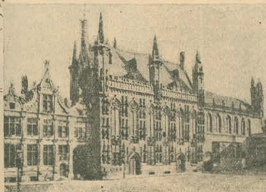
BRUGES.—O palacio do municipio, um monumento architectonico de consideravel valia, que escapou a sanha destruidora do inimigo.
