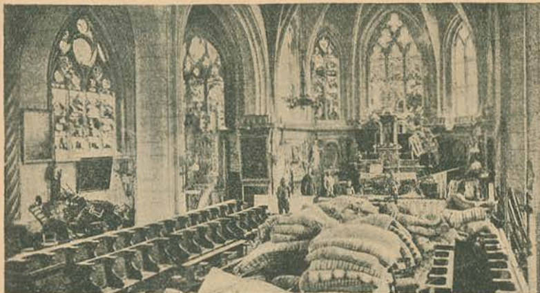
Na nave central da igreja de Chateau-Thierry: As pilhas de colchões que os alemães não tiveram tempo de levar, quando da sua retirada.
