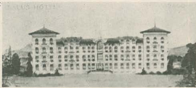
A parte do grandioso hotel Salus que está concluida
