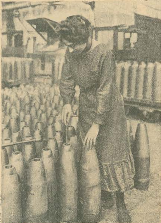
N'uma fabrica de munições em França.—Verificando os morteiros de 155.
