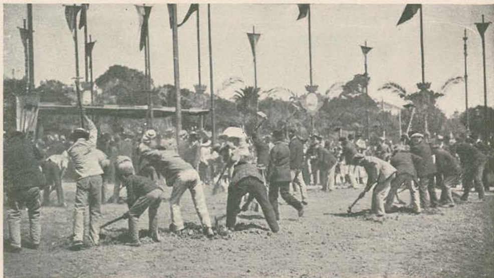
Os operarios municipaes abrindo os caboucos
