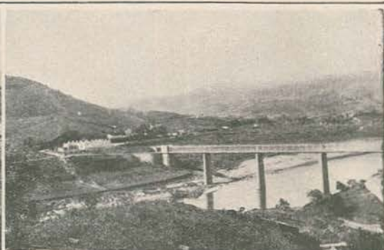
Vista geral do Pocinho com a ponte sobre o rio Douro
