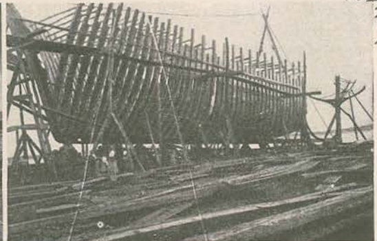
Esposende. — O estaleiro d'esta villa tem redobrado de atividade nos ultimos tempos. Estas fotografias dão os aspectos de dois barcos que all se estão construindo. Aquelle d' que ainda se vê o cavername deve deslocar 1.000 toneladas; o outro que está quasi pronto (600 toneladas) pertence á casa Pinto da Fonseca & Irmão, do Porto.
