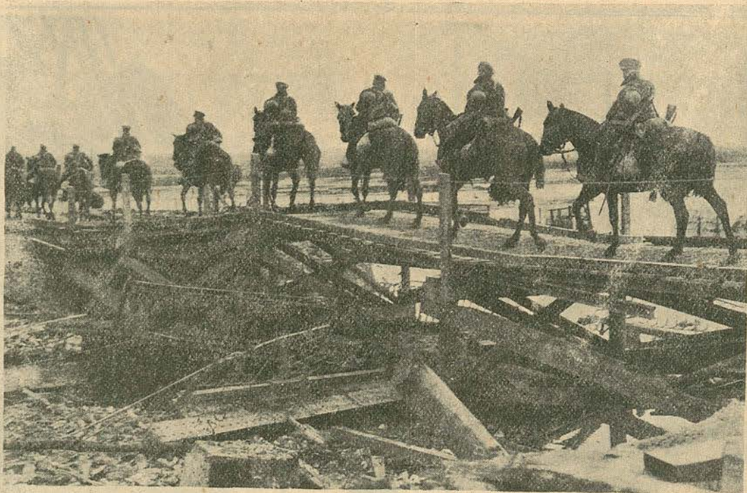
Um troço de cavalaria passando por cima de uma ponte provisória em substituição de outra destruída pelos alemães.
