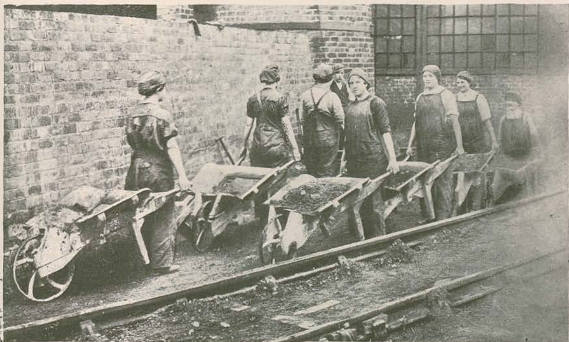
Transportando terra de excavações feitas para a instalação de bombas hidraulicas
