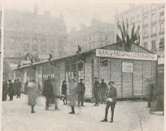
Vista geral (parte sul)
