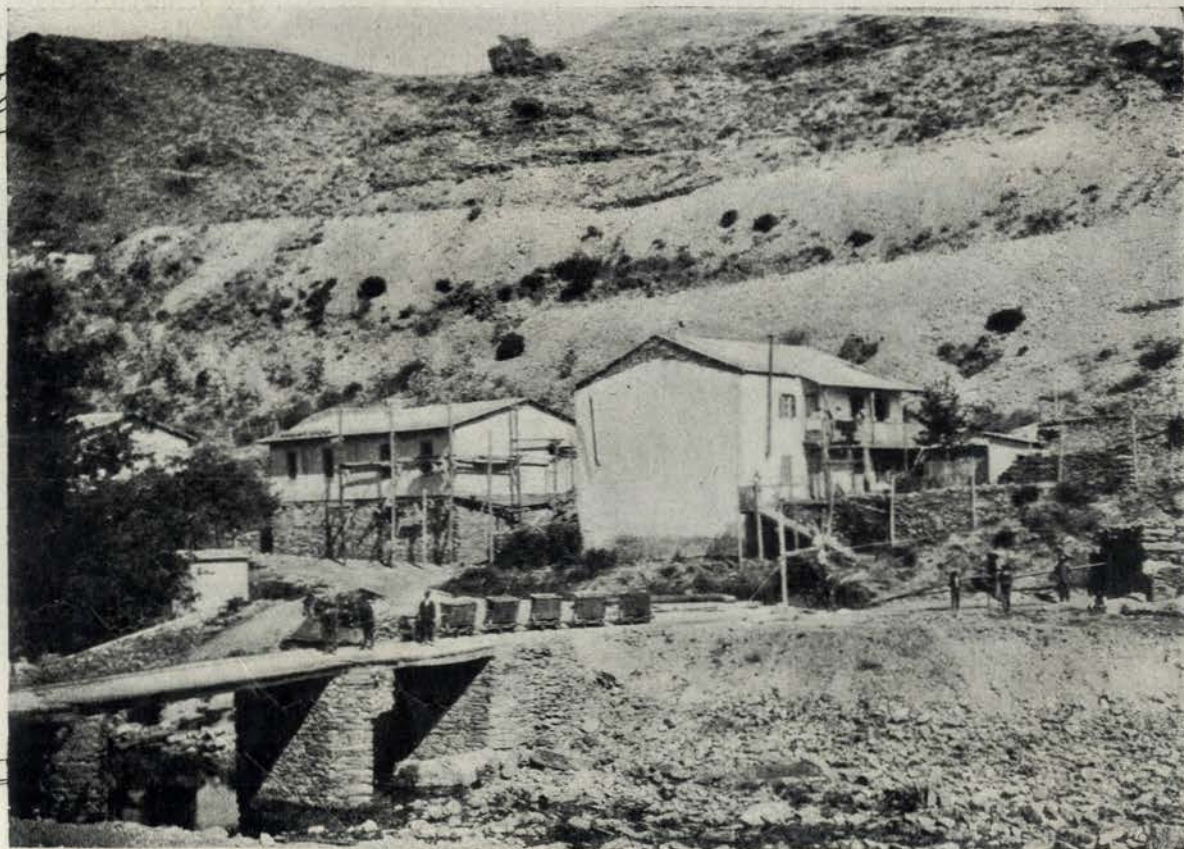
Um combolo de wagonetes transportando minerio da contra-mina para a lavaria. Na extrema direita vê-se a entrada da contra-mina.
