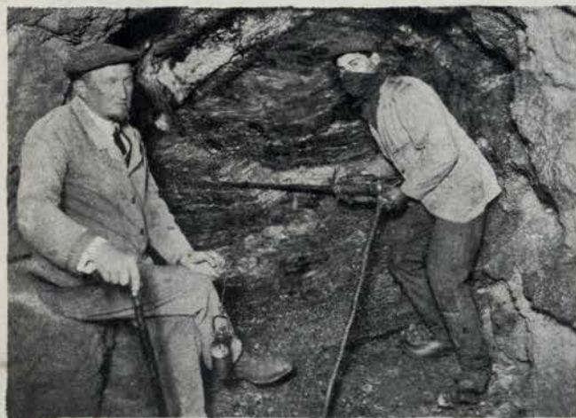
2. Avançamento do filão de Santa Barbara, a 100 metros de profundidade, e situado ao fim de uma galeria de 1500 metros. Um mineiro fazendo furos com a perfuradora para os cartuchos de dinamite, a cujo trabalho assiste o director das minas da Borralha, sr. Paul Marljon. 3. Interior da central hidro-electrica de Mizarela, com a potencia maxima de 900 HP.
