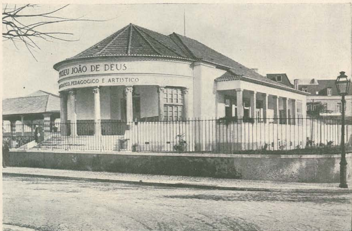
Fachada do edificio Jardim-Escola João de Deus
