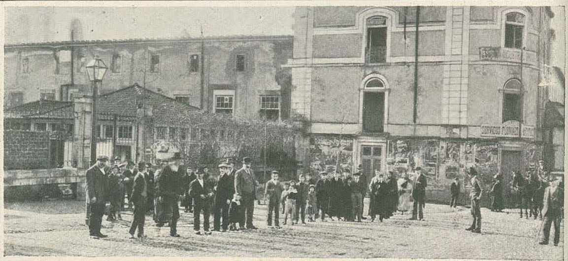
1. Os dois corpos da Escola Brotero destruidos pelo fogo, — 2. A frontaria da Escola Brotero e o corpo do edificio (lado poente).
