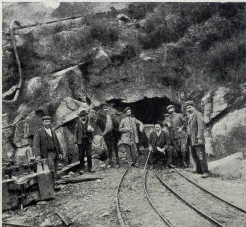
A entrada da galeria que conduz ao pizo do elevador com 32 metros de profundidade.
