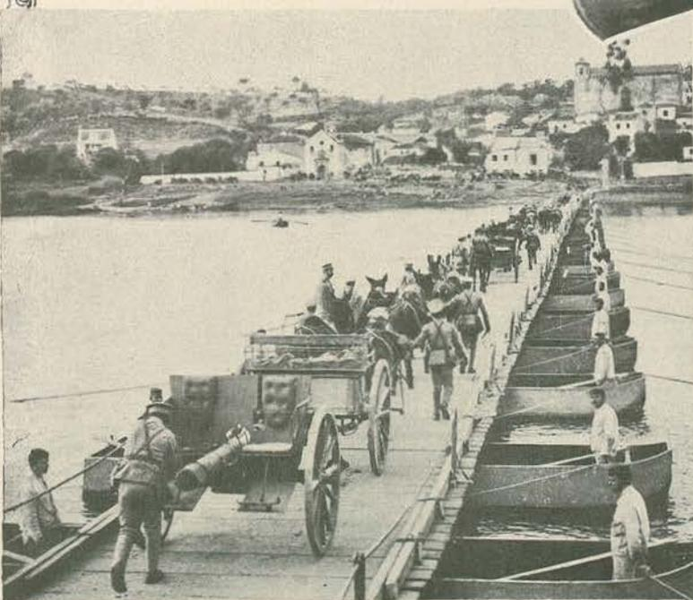
A artilharia no regresso dos exercícios, passando a ponte de barcas, montada pela engenharia, secção de pontoneiros, entre o Arriplado e Tancos.
