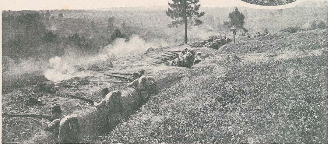
1. Cessar fogo!...—2. Barquinha .— Um entrincheiramento na cota 114
