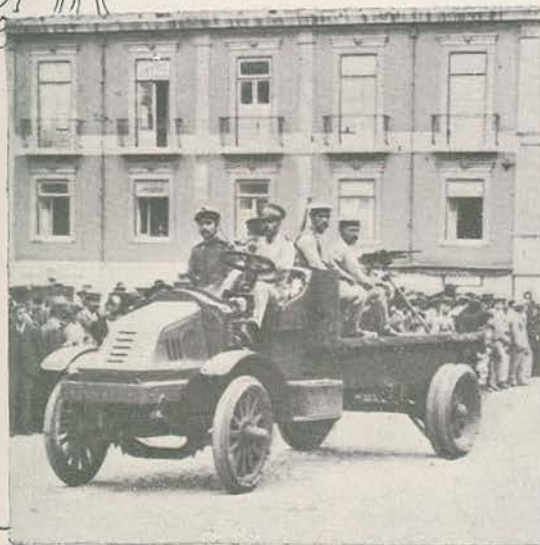
Uma metralhadora conduzida em um camion
