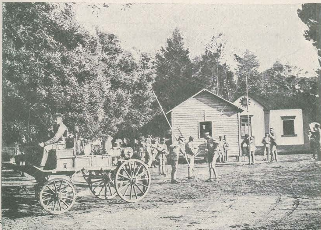
Montagem e reparação de uma linha telegraphica da estação ao quartel general
