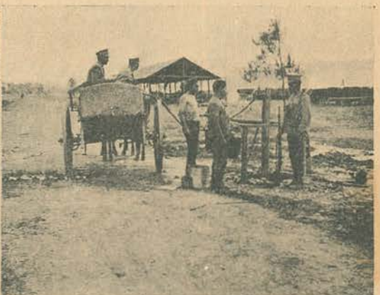
Entroncamento. —Abastecimento de água para o acampamento.
