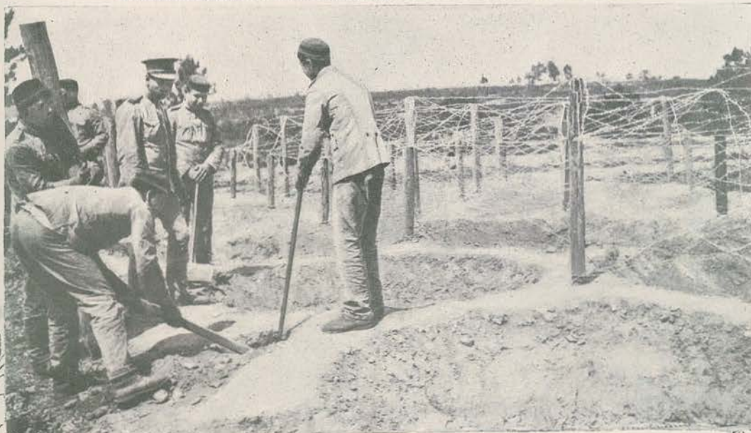
Defezas de acesso das trincheiras com arame farpado
