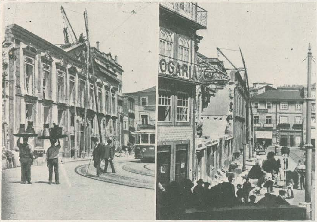
1. Procedendo á descida da estatua do Porto, do edificio velho da camara municipal. — 2. Na occasião que uma das varas que seguravam o guindaste resvalou, caindo a estatua em cima de um estrado de madeira que tinham posto de prevenção, vendo-se as varas vergadas. (Clichés do distinto fotografo amator sr. José Humberto Gonçalves).
