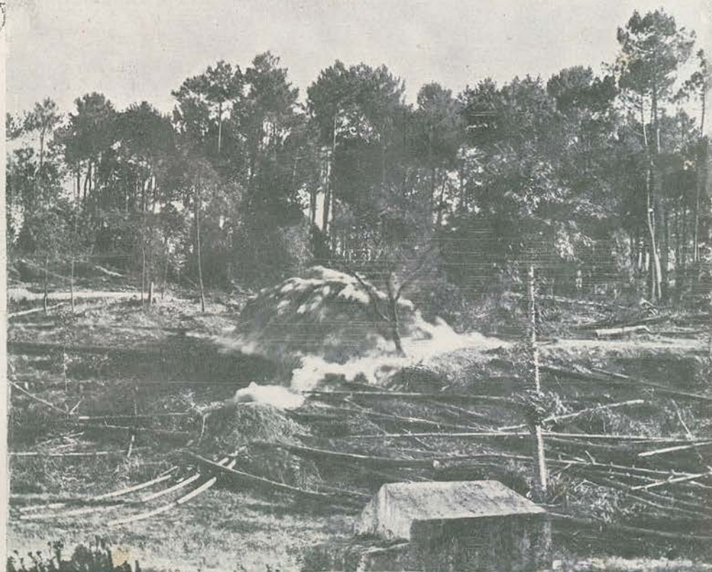
Destruição de uma trincheira blindada com a explosão de uma mina
