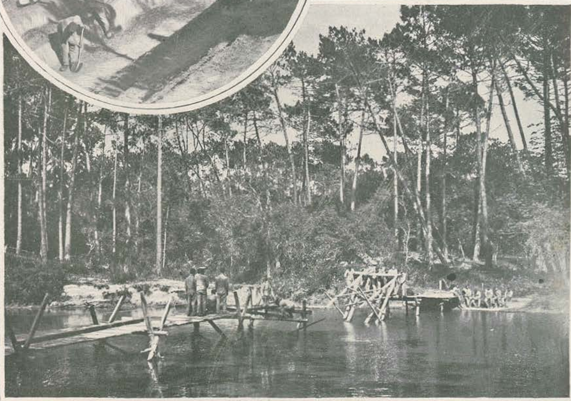
2. Trabalhos de sapa.—3. Construção de uma ponte improvisada; lançamento de um cavalete
