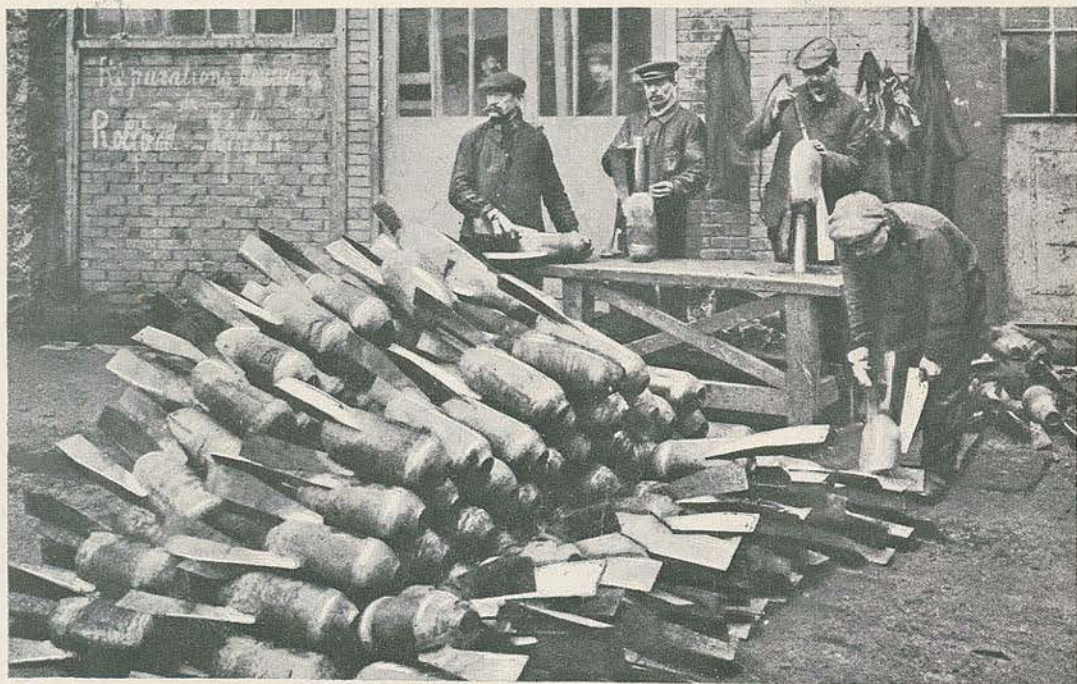
As pás de que são munidos os torpedos para fazel-os seguir a necessaria trajetoria
