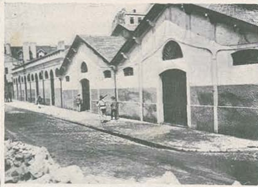
O edificio do Matadouro e talho de carnes na Manutenção Militar, recentemente inaugurado
