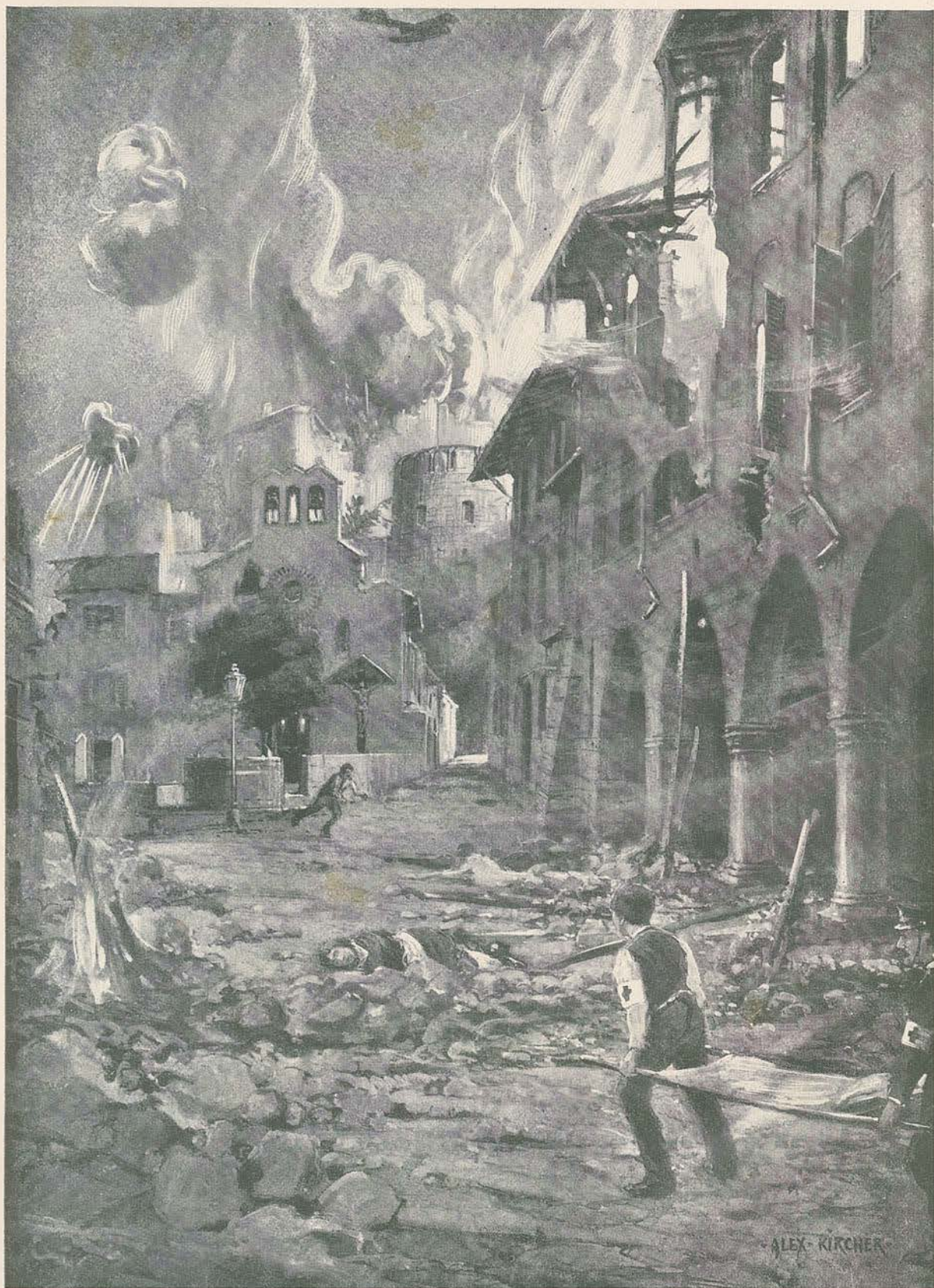
Um trecho da cidade de Kastell, no Gorz, durante o bombardeamento
