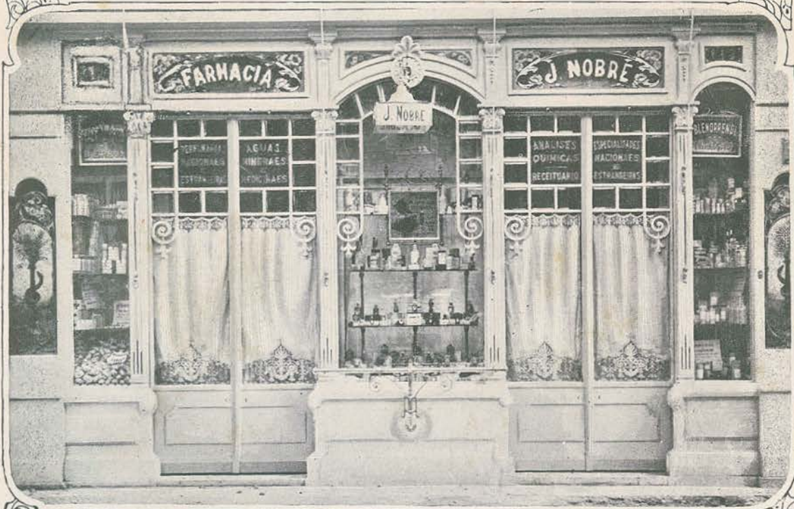
A fachada do novo estabelecimento
