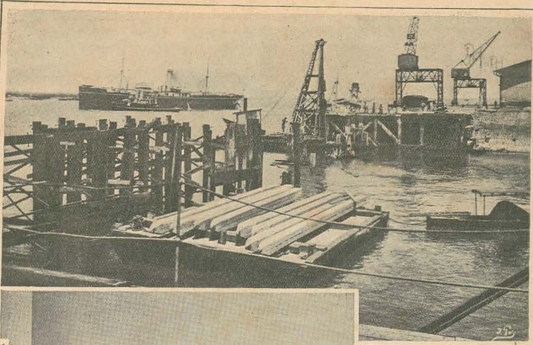
Ponte-caes de Lourenço Marques. Início da construção do prolongamento para Juzante
