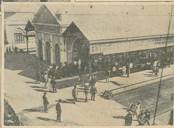
Gare da estação do caminho de ferro de Lourenço Marques
