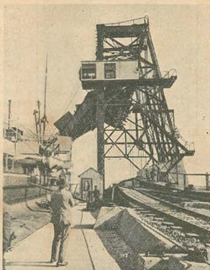
A nova instalação carvoeira permitindo carregar 500 toneladas por hora (os vagons são levantados virados e vasados dentro dos porões do navio acostado)
