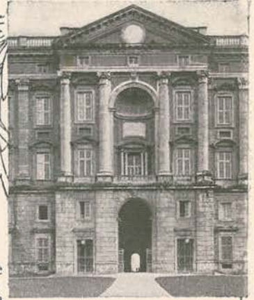
Um detalhe da frontaria do magnifico palacio real de Caserta
