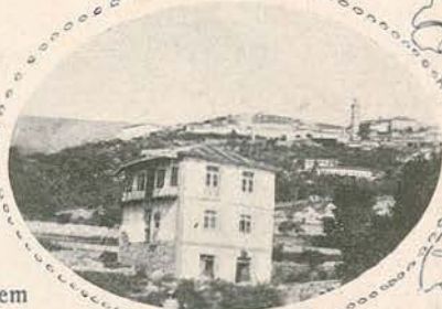
Vista da Covilhã, tirada da estação do caminho de ferro
