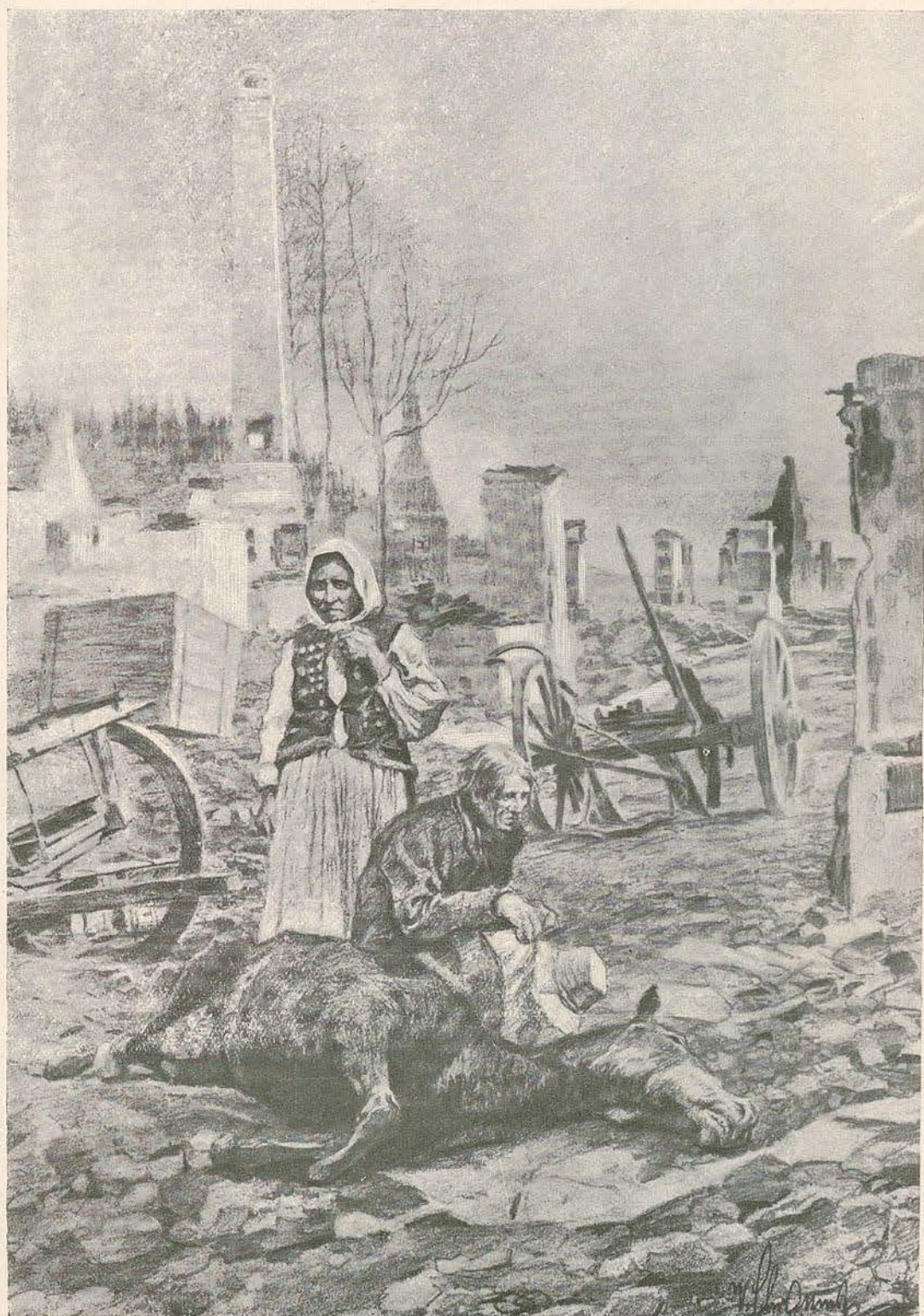
Quadro desolador depois da retirada dos russos
