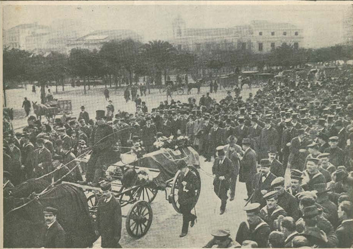
O armão dos bombeiros conduzindo o feretro passando na Rotunda da Avenida
