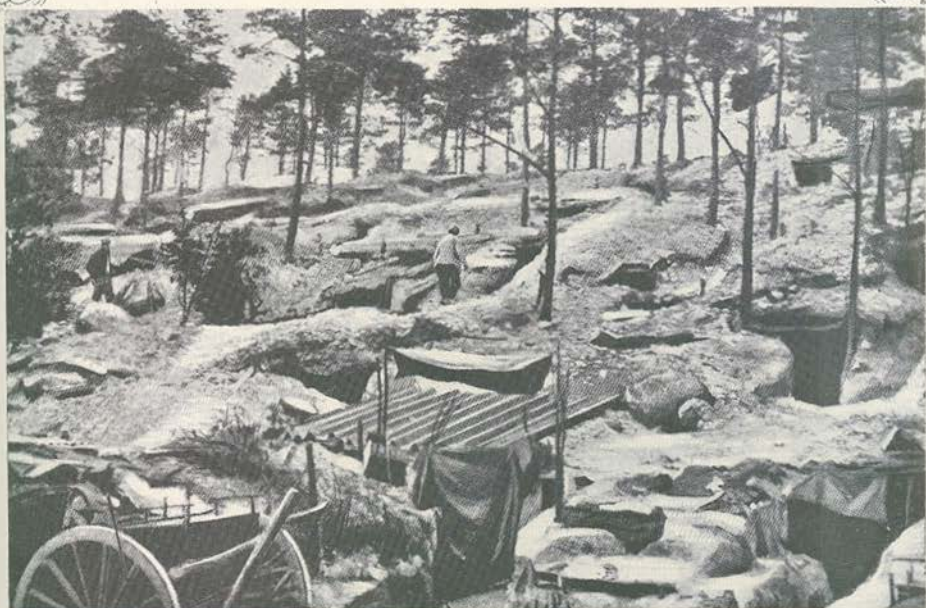
Os abrigos abertos pelas tropas francezas na região da Champagne depois da grande batalha que ali se feriu ultimamente: dão á paisagem o aspeto d'uma enorme pedreira em exploração.
