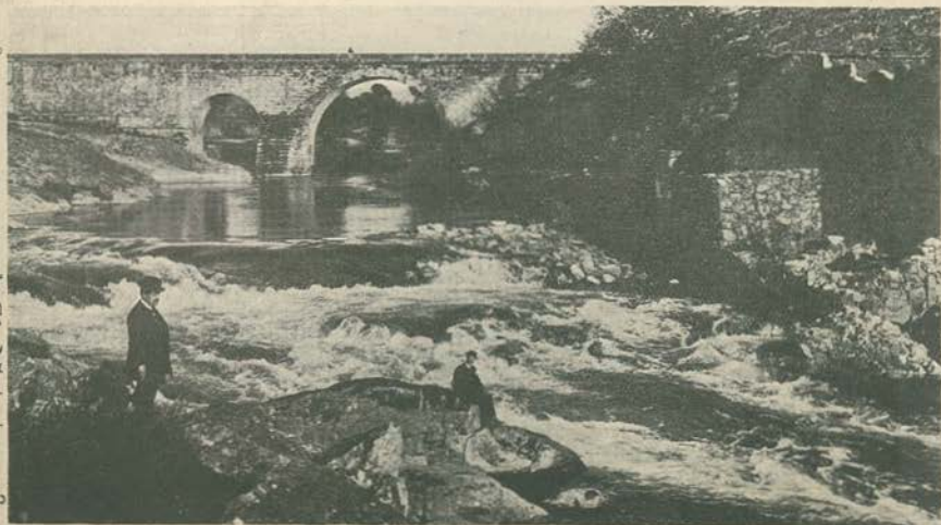
«Ponte Nova» sobre o Mondego
