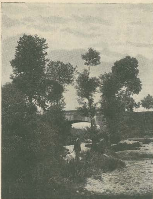
Trecho da Ponte das Olas
