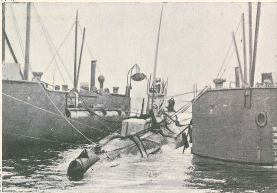
O submarino inglêz E-15, salvo por um navio dinamarquez, é suspenso com cabos d'aço entre dois pontões.
