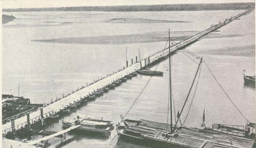
A ponte de barcos em Weichel que, apesar de ter 1.200 metros, foi construída em três dias
