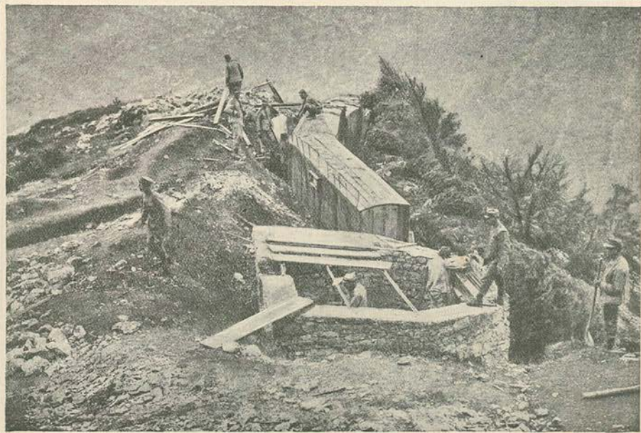
Construção de uma trincheira em cimento armado no cume de uma montanha nas posições mais avançadas do exercito italiano
