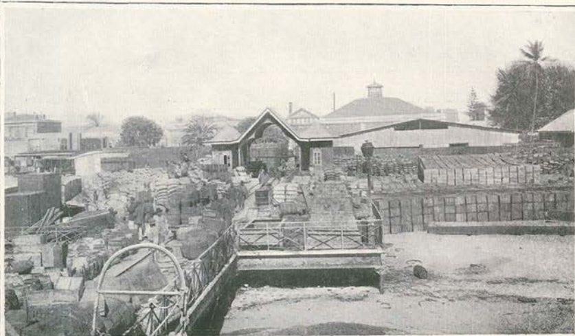
Mossamedes: 1. O guindaste da ponte-caes descarregando as remessas para as nossas tropas.—2. As remessas desembarcadas, expostas ao tempo e á ação do mar, á espera de serem transportadas para o Lubango.
