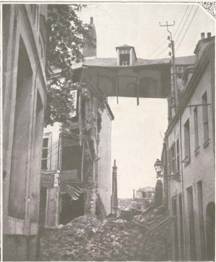
O que resta de uma casa em Arrás depois do bombardeamento (Clichés Excelsior).
