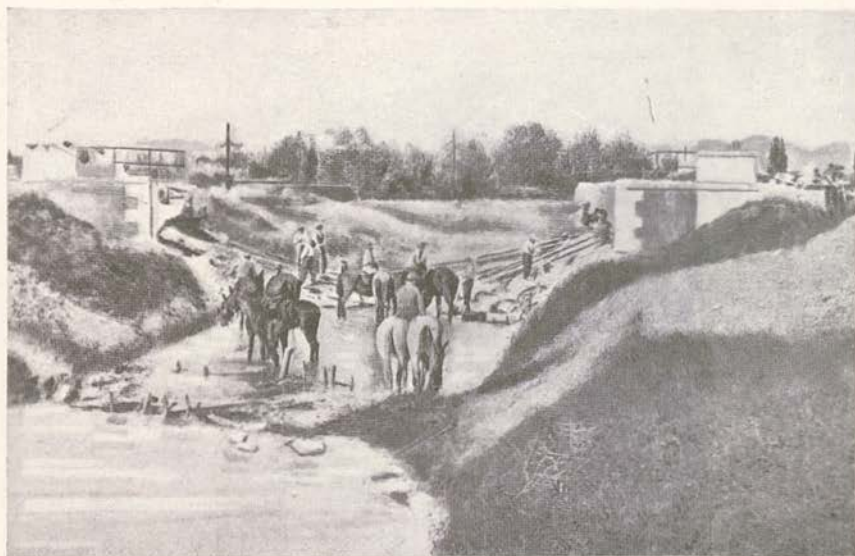
A engenharia italiana reconstroe uma ponte que os austriacos haviam feito saltar
