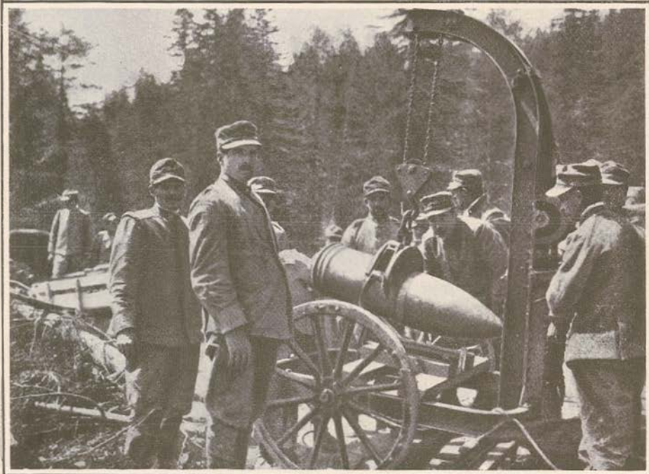
Um projétil de 365 suspenso de um guindaste para dar entrada na respetiva peça
