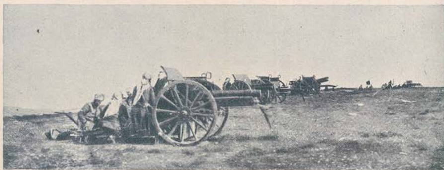
1. Um grande rombo produzido no tombadilho de um couraçado Inglês produzido pelo bombardeamento dos fortes turcos dos Dardanelos. 2. Um comboio de camelos a caminho de Gallipoli.—3. Bateria em posição na península de Gallipoli
