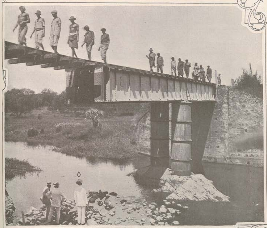
Os indígenas dirigindo-se para o trabalho de reparação da ponte, sob a direção do engenheiro ◊ sr. Sá · Carneiro
