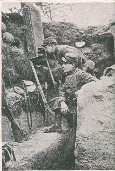
Aspeto de um trecho da linha occidental, onde se emprega o periscopio, engenhoso aparelho pelo qual se pode observar o movimento do inimigo sem que este dê por isso.
