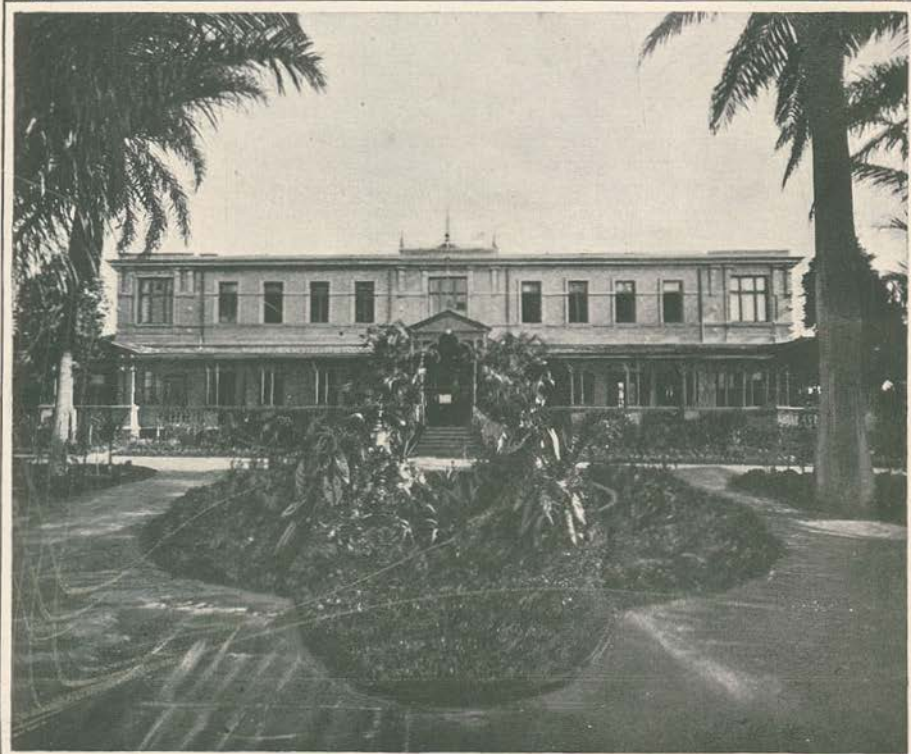
Fachada principal do Instituto Agronomico de Campinas
