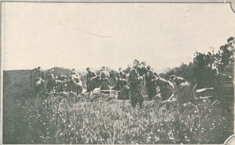
1. Na Argonne: Construção de uma trincheira nos arredores de Saint-Hubert.
