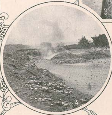
2. O sr. Fausto de Figueiredo, iniciador da transformação do Estoril—3. As fundações do novo estabelecimento termal—4. A destruição, pela polvora, de blocos de pedra.
