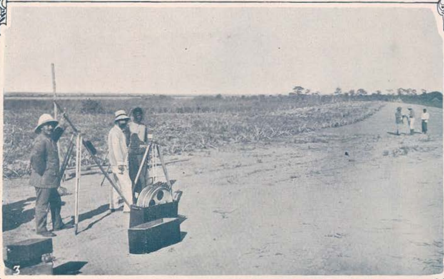
3. Uma experiência com o aparelho de invar , em Cazeze—(«Clichés» do distinto fotógrafo amador Sr. Augusto Casimiro).
