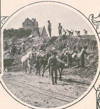
Trabalhos de desaterro para o nivelamento da pelouse
