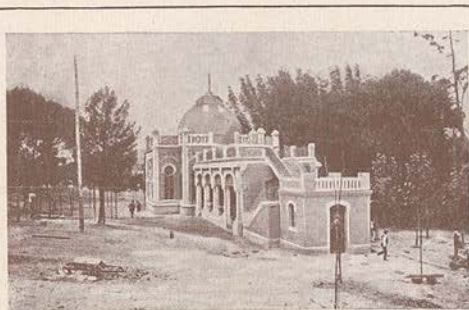
Pavilhão de Vidago
