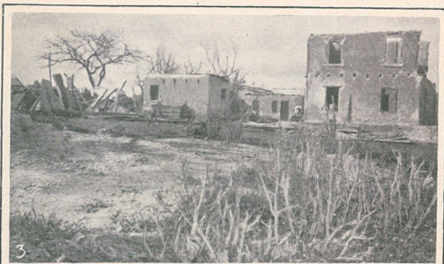
O edificio destruído da Companhia do Niassa
