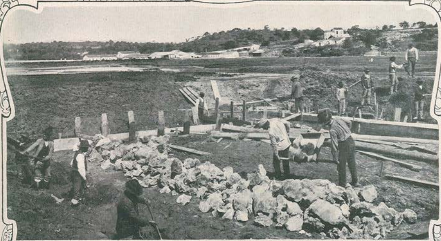
1. Trabalhos para a construção da ponte que vae ligar a estação. Ao fundo o convento da Gloria onde actualmente está instalada a Guarda Republicana.—2. ponte provisoria no local onde vae ser construida a definitiva.—3. Os primeiros trabalhos para a construção da estação.—(cliclêch's do distinto fotografador amador sr. Antonio C. Santos.
