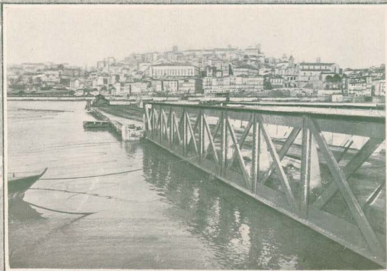
A água que alcançou a ponte do elevador
