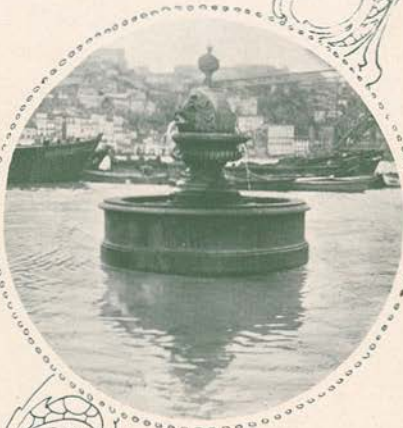
Um aspecto da inundaçáo do lado de Gaia.
