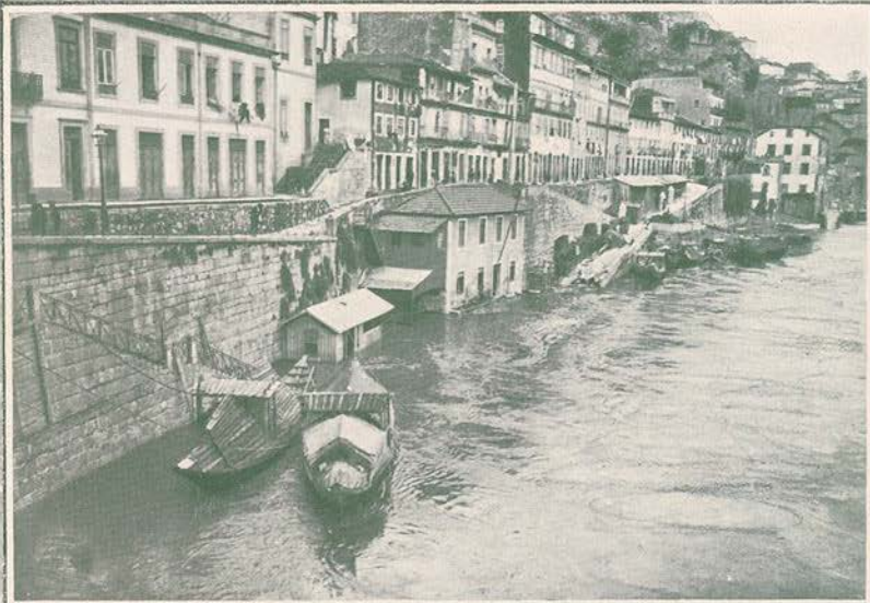
A cheia no rio Douro: O posto fiscal dos guindastes inundado
