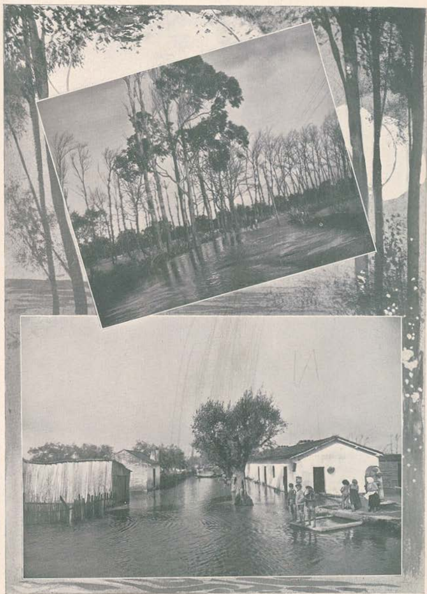
1. A estrada da Tapada a Almeirim inundada.—2. Um trecho do lugar da Tapada inundado.
