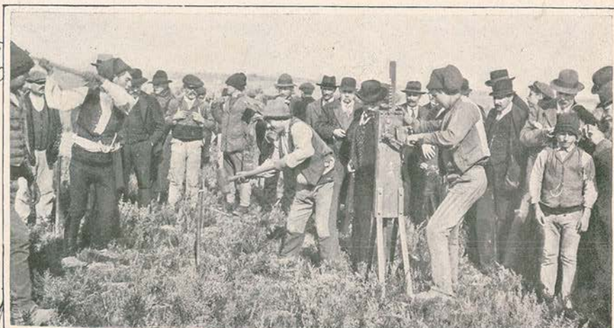
O jurí assistindo ao serviço da perfuração
