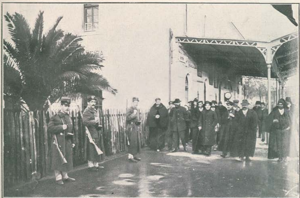
Na estação da Malveira: a estação guardada pela Guarda Republicana e um grupo de ferro-viários («Clichés, Benoitte)
