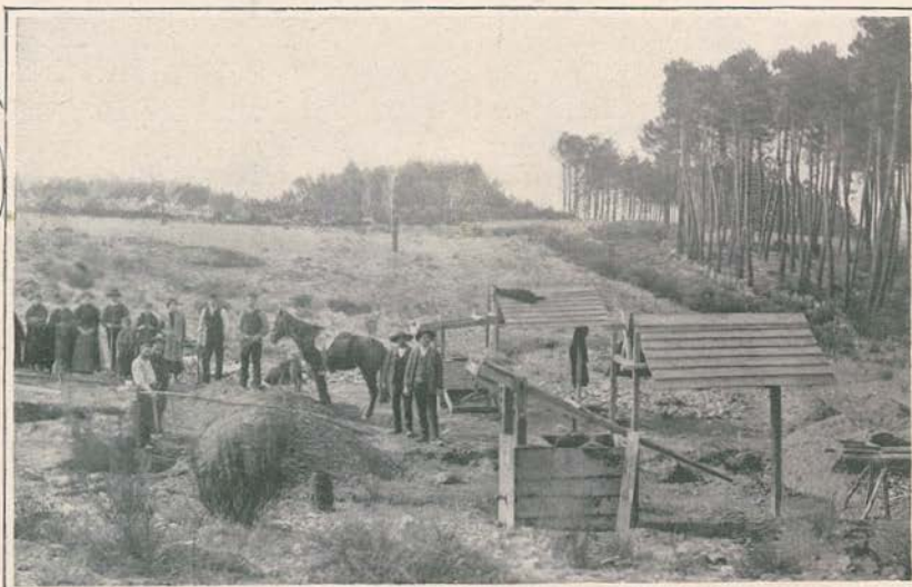
Lavagem de aluviões de estanho por meio de crivos manuaes na mina da Fonte do Selxo. (Guarda).
