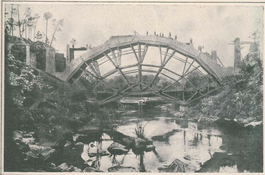
Caminho de ferro de Vale de Vouga: A ponte de construção original cujo vão é de 53 metros a que foi assente em dois rochedos das margens do Vouga entre S. Pedro do Sul e Vouzela, («Cliché» do distinto amador sr. J. M. Batalha.)
