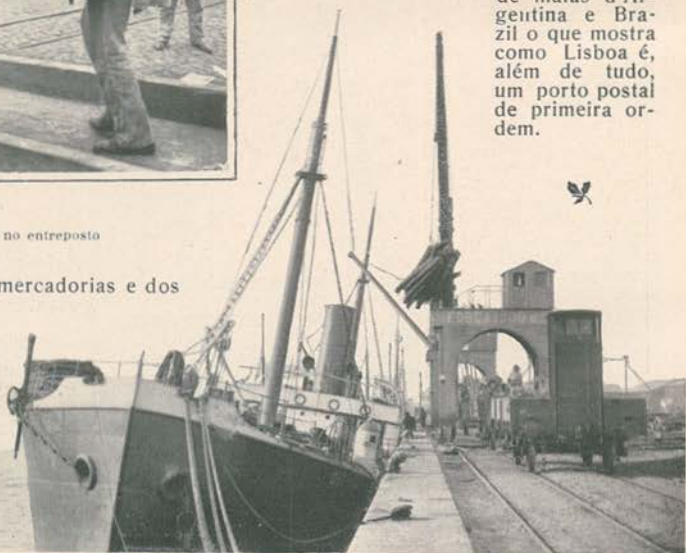
A descarga de toros em Alcantara
