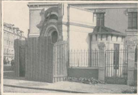
Edifício onde vai ser instalado o relógio público
