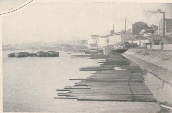
Vigas n'uma das docas
