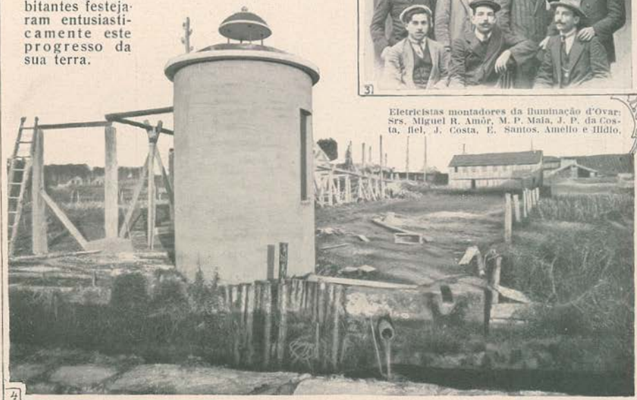
4. Instalação da bomba centrífuga movida a electricidade para o fornecimento d'agua á fabrica de electricidade d'Ovar. (Clichés do distinto fotografo amador sr. Ricardo Ribeiro)
