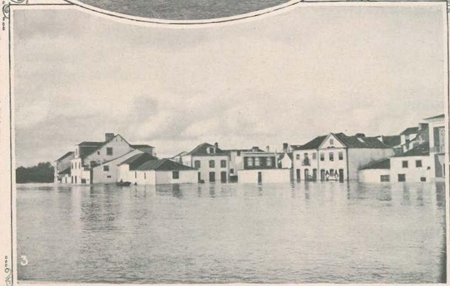
A rua do Sol, Barquinha, alagada.
