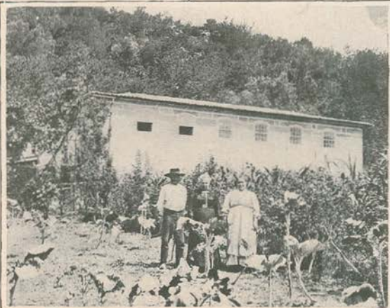
1. A casa do sr Manuel Fernandes Canela em Espinho, concelho de Vieira — 2. A capela de Santa Isabel em Espinho onde se realisaram as festas — 3. A casa do abastado proprietario sr. Manuel Duarte em Cantelães, concelho de Vieira — (Clichs do photographo João Canela)
