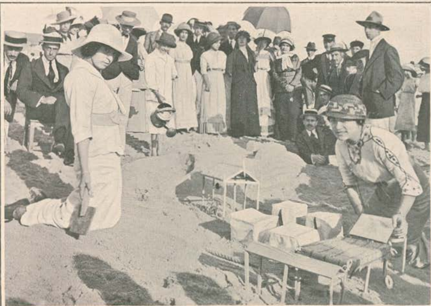
Uma das construções classificadas.
