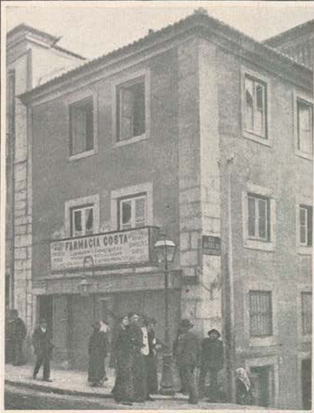
3. O prédio onde se deu a explosão
