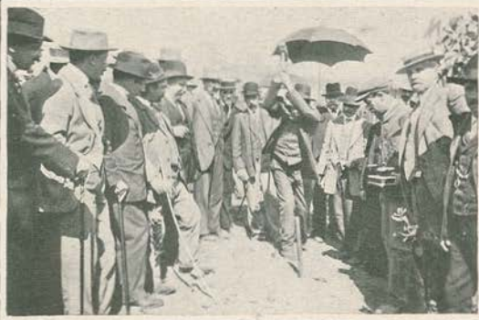
A abertura d'um furo para meter o explosivo.
